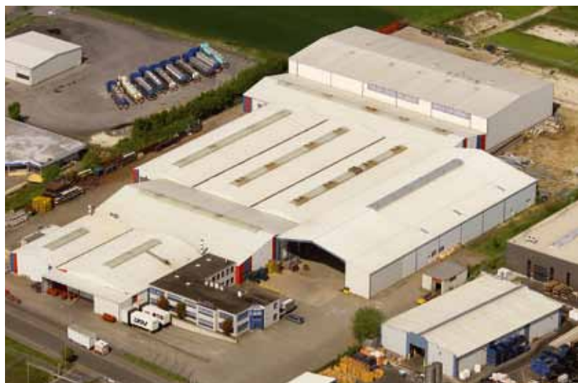
Stammwerk Sinusverteiler, Wettringen
