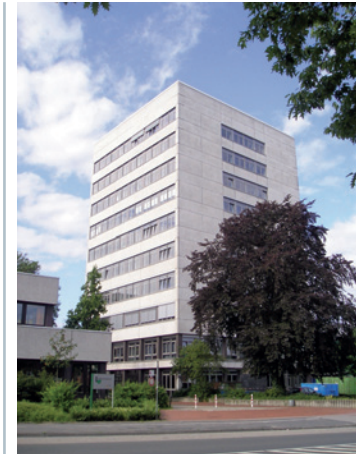
Bild 1: Die Schule nach der Sanierung
