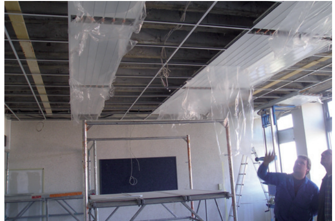
Bild 3: Während der Montage: Hier sind die einzelnen Heiz-Kühlelemente und ihre Verbindungen zu erkennen
